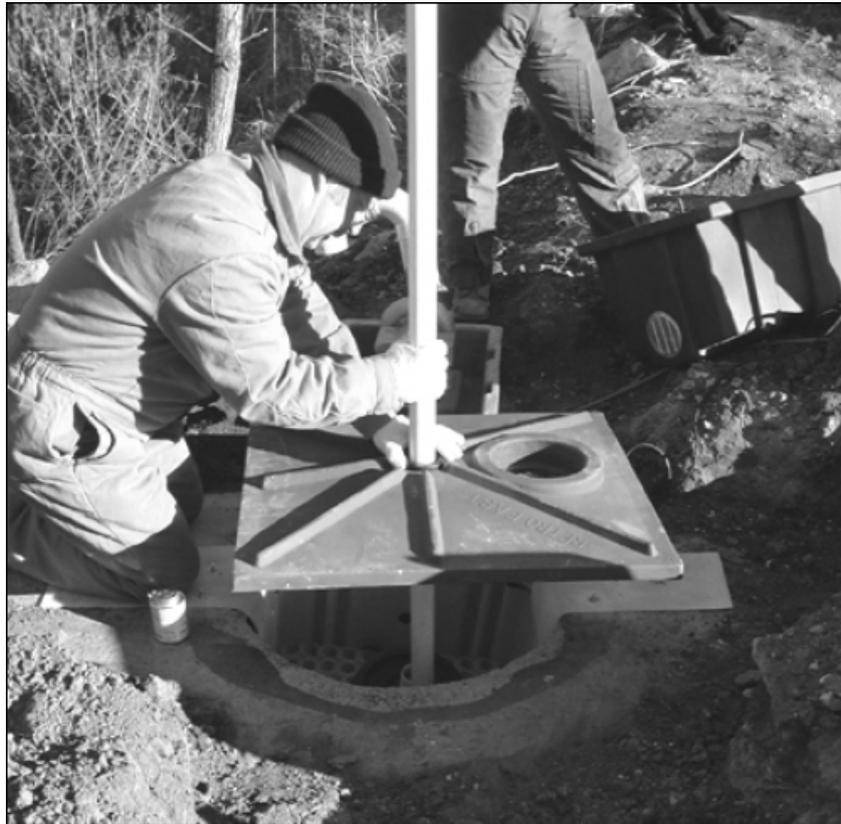
6. Просверлите в бетонной крышке отверстие диаметром 160 мм и вставьте в нее кусок ПВХ трубы диаметром 160 мм (труба для наружной прокладки). Длина трубы определяется Вашими условиями так, чтобы верхний край трубы с заглушкой (которая вставляется в раструб) был на уровне земли.
